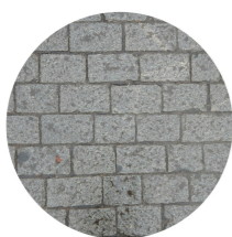
Dlažba - parking před Píseckou branou
